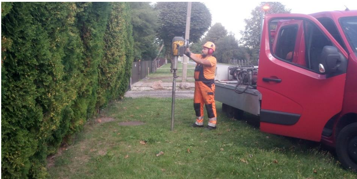
1 pav. Lauko darbai
